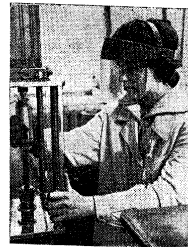
Рис. 28. Лабораторный аппарат для наполнения аэрозольных упаковок сжиженными газами под давлением:
